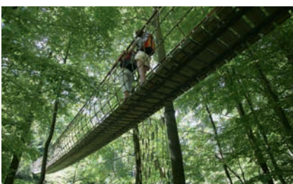
Netbrug + houten loopvlak, lengte 40 m
