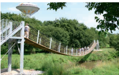
Netbrug + houten loopvlak, lengte 54 m
